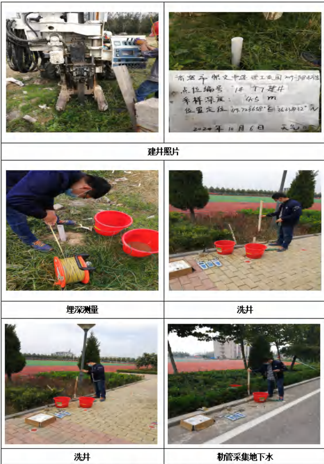
图 5.2-2 建井现场照片
